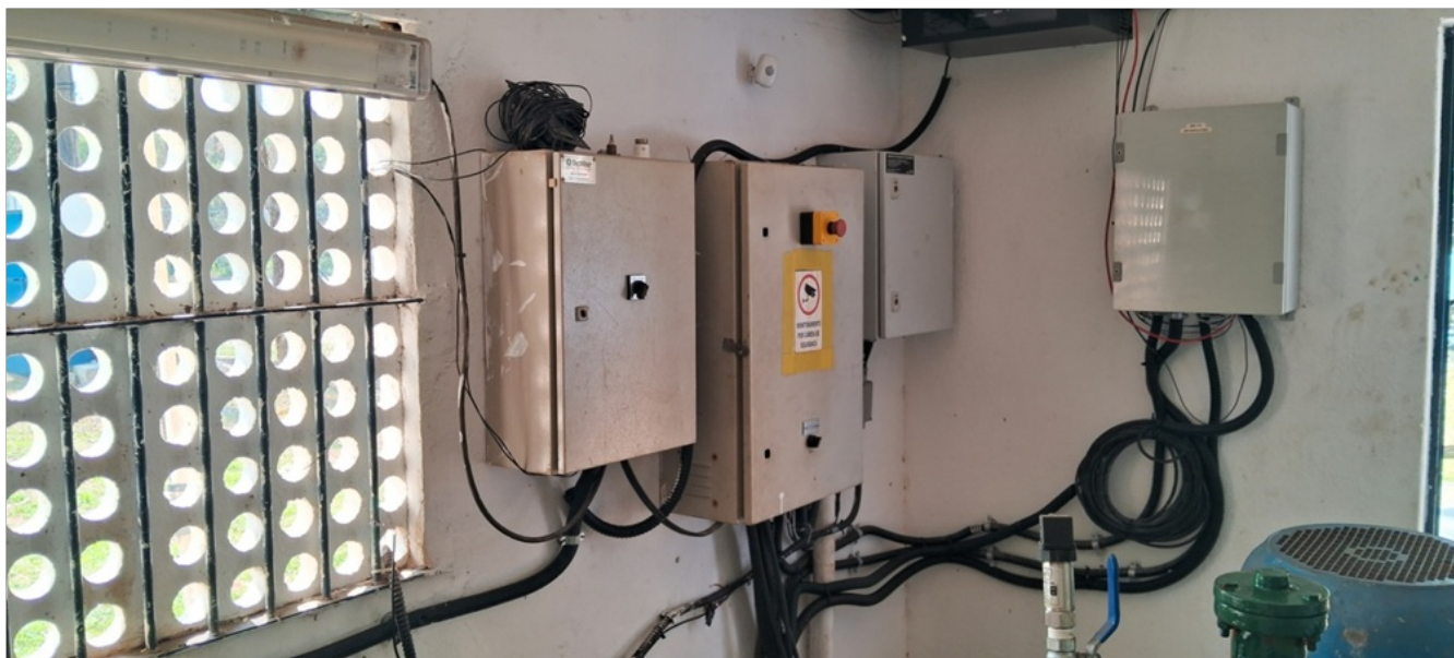
Foto 4 - Vista interna da estação, telemetria e ventilação / iluminação natural.
