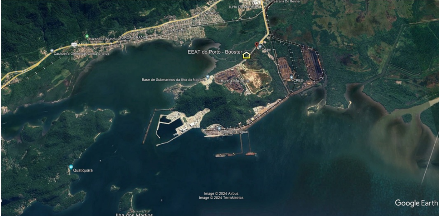
Foto 1- Vista da localização e da área de influência da EEAT do Porto ( 22° 54'32,4" S / 43° 49'47,7" O )
